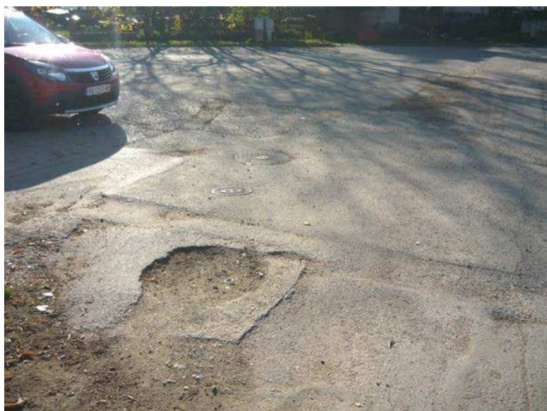
Sl. 5. Postojeći poklopci fekalne i vodovoda
