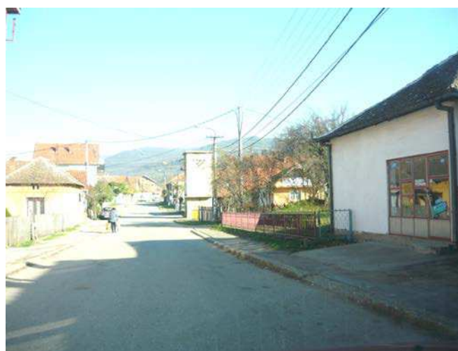
Sl. 2. Zadržava se postojeći kolovoz, bez oštećenja
