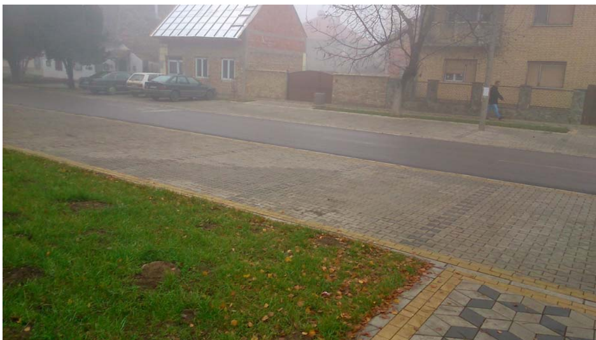
Слагање бетонских плоча на паркингу
