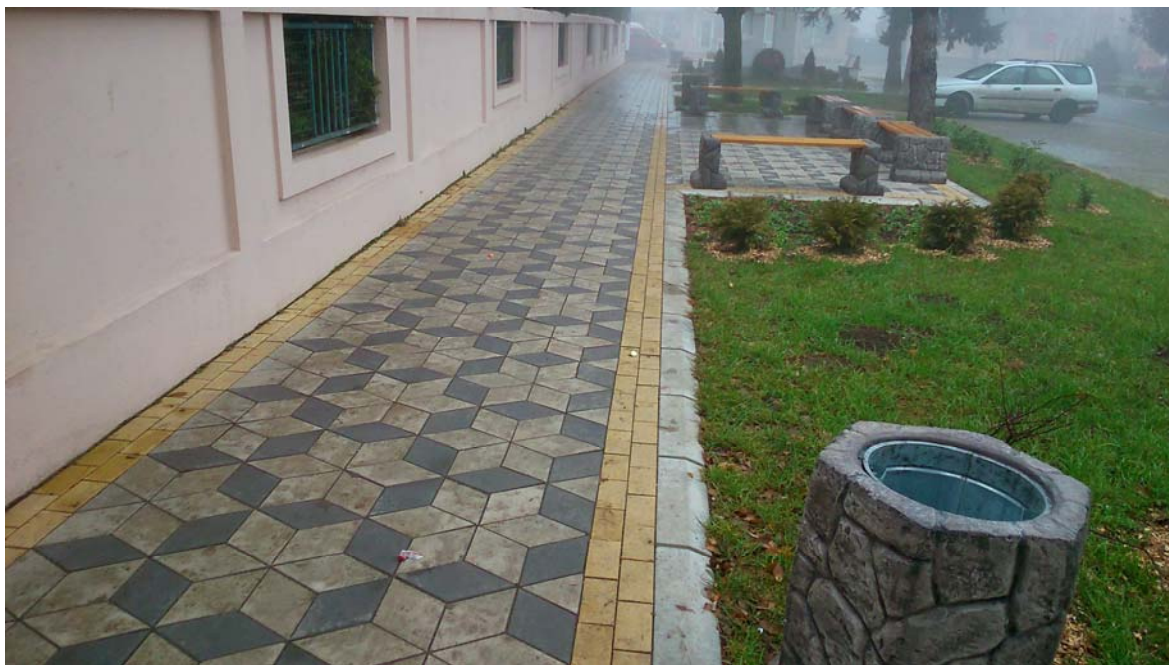
Слагање бетонских плоча на пешачкој стази
