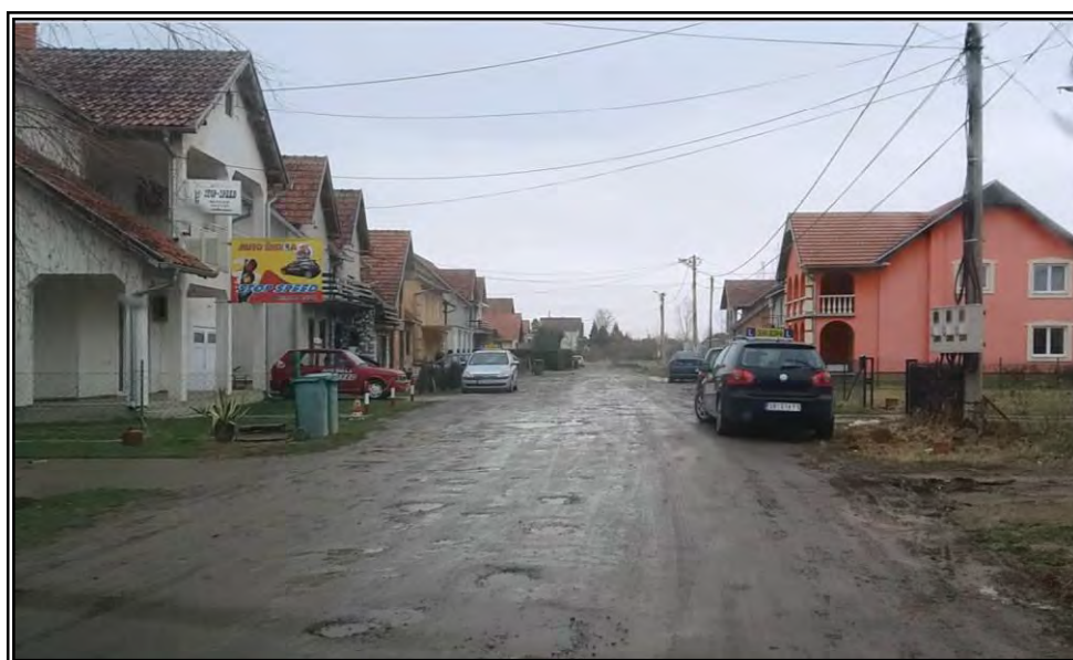
Slika 3. Postojeće stanje ulice Aleksića Imanje
