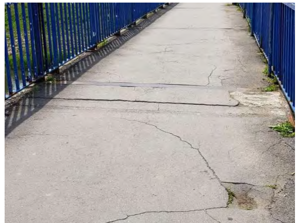
Слика бр.6: Оштећења хабајућег слоја
