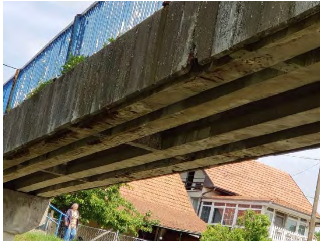
Слика број 5: конструктивни склопсредњишег отвора моста
