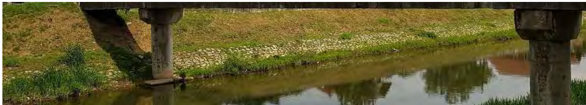
Слика бр. 10: Обалоутврда корита Млаве у зони моста
