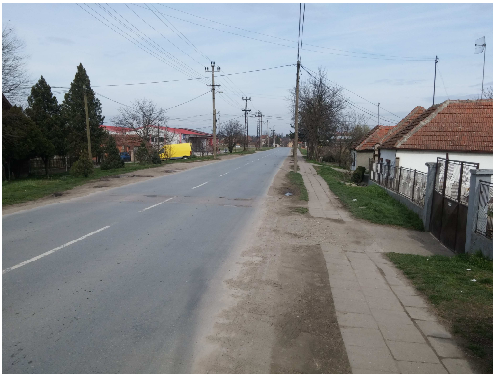
Slika 3. Postojeći izgled dela Barske ulice
