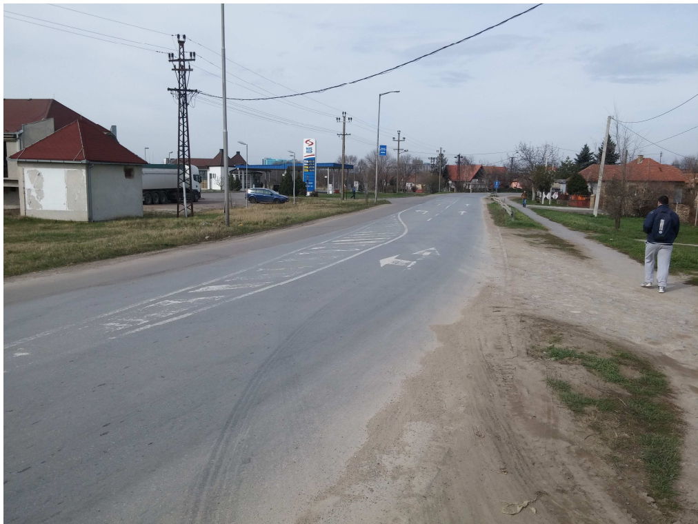
Slika 2. Postojeći izgled dela Barske ulice
