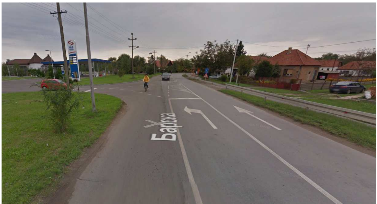
Slika 8. Izgled SSG-a u postojećem stanju
