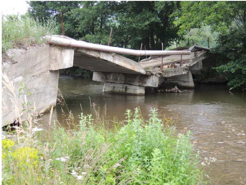
Слика 1-1: Постојеће стање мостовске конструкције
