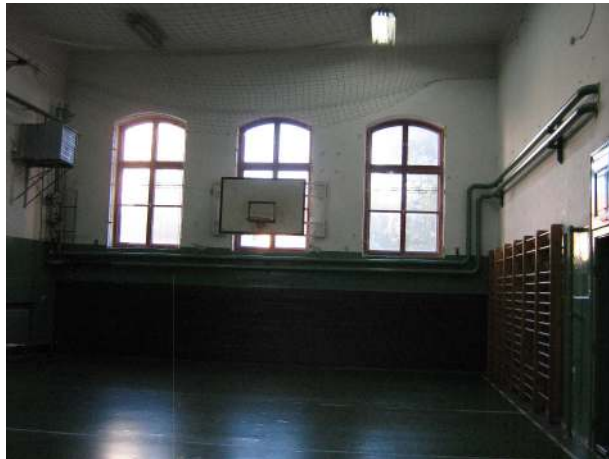
slika 1. postojeće stanje – unutrašnji toplovod
