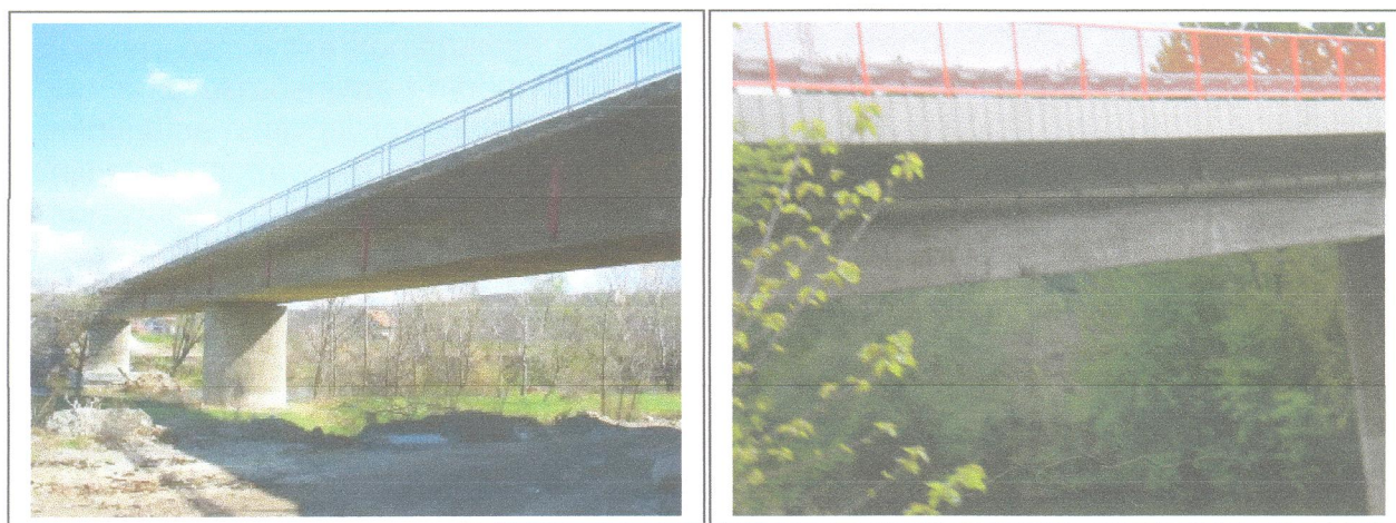
Sl.1. Slike mosta pre i posle rekonstrukcije
